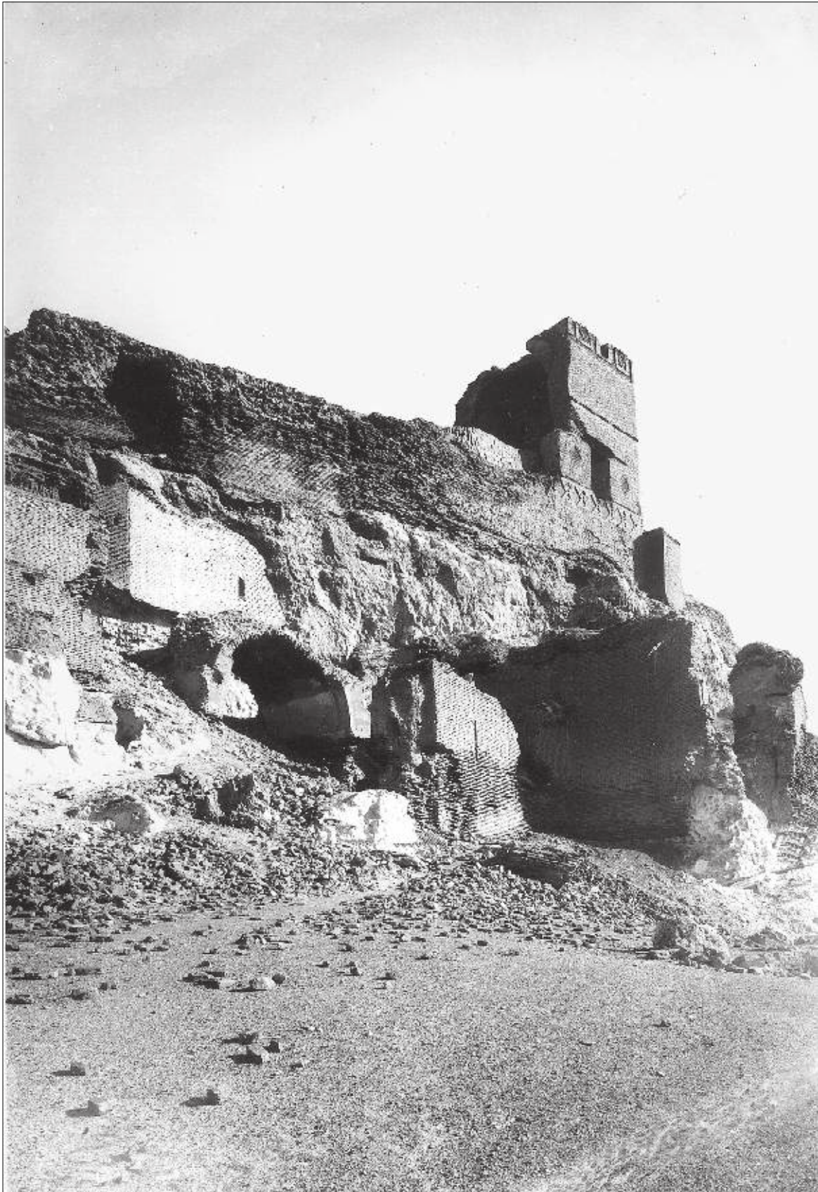
لوحة ٨,٥ قلعة جعبر، من الخارج، من سنة ٥٦٤ هـ/١١٦٨ م وما بعدها على الأرجح (من إعادة بناء نور الدين)، ومن سنة ٧٢٦ هـ/١٢٢٥ م (من إعادة بناء حاكم دمشق المملوكي، تنكيز)، سورية. (أرشيف الصور الفوتوغرافية، متحف أشموليان، أكسفورد، نيغاتيف س٦٦٦٠)
