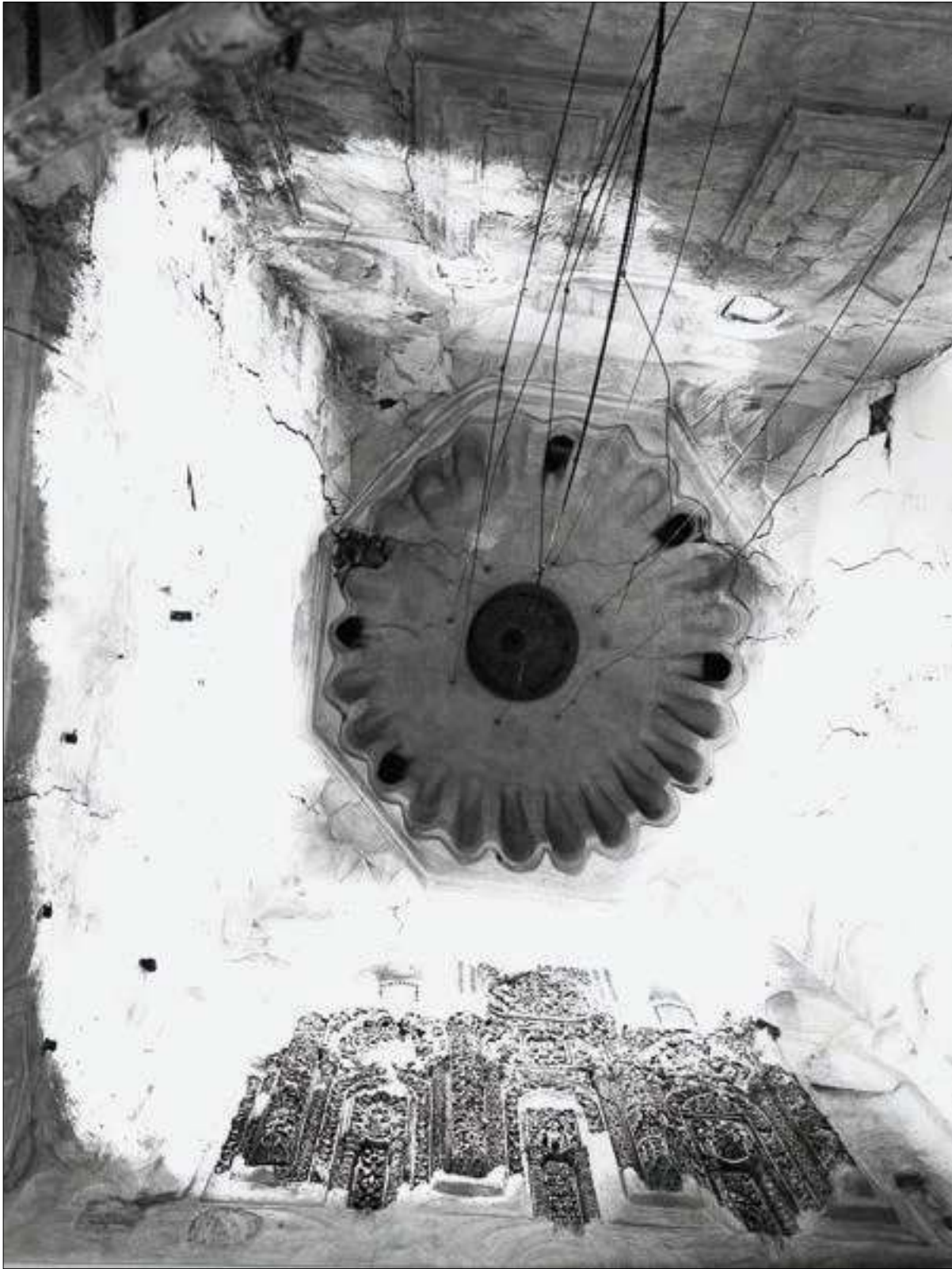
لوحة ٤,٥ الجامع النوري، القبة أعلى المحراب، (صورة مأخوذة قبل إعادة ترميمه سنة ١٩٤٠م)، محراب سنة ٥٦٦-٥٦٨هـ/١١٧٠-١١٧٢م، أعيد بناء القبة بعد ذلك، الموصل، العراق
